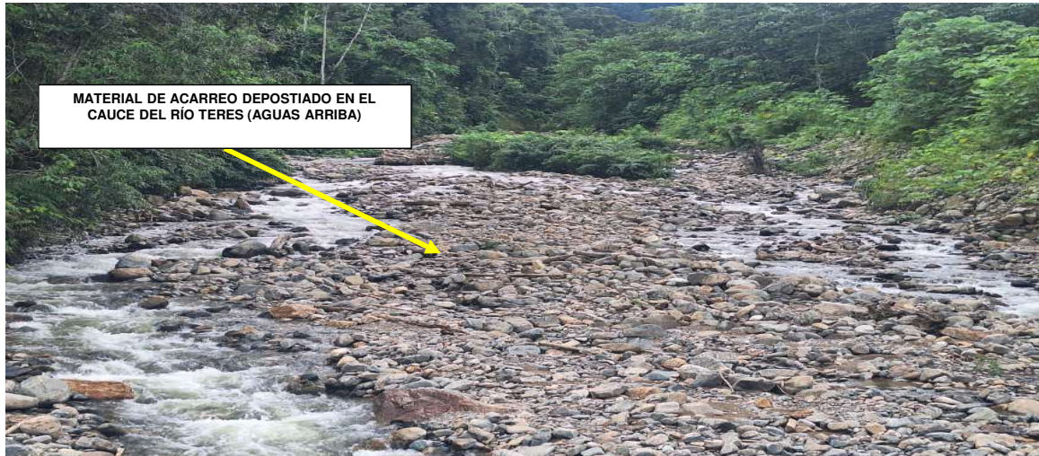
FIGURA N°03: VISTA DE CAUCE DEL RÍO TERESA COLMATADO POR EL MATERIAL DE ARRASTRE.
