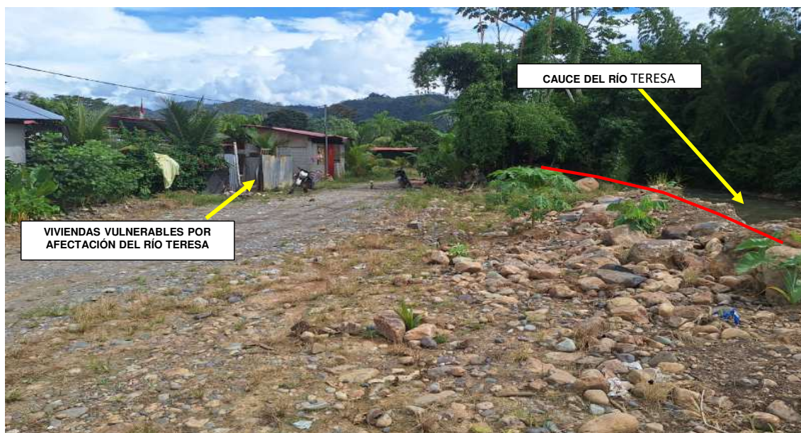
FIGURA N°02: VISTA DE LAS VIVIENDAS VULNERABLES A INUNDACIÓN DEL RÍO TERESA, EN EL SECTOR AGUA DULCE, DISTRITO DE UNIÓN ASHÁNINKA, PROVINCIA DE LA CONVENCION - CUSCO.
