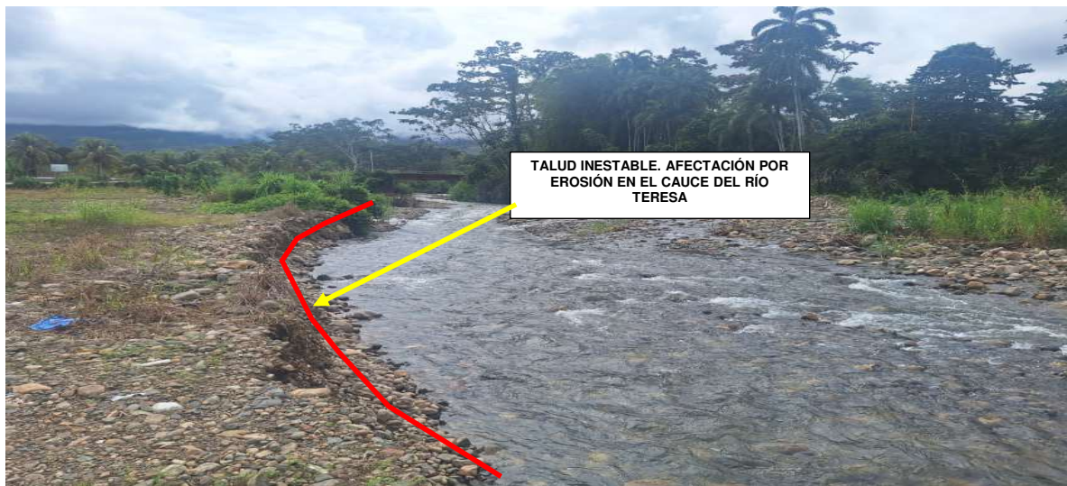
FIGURA N°01: TALUD INESTABLE A CAUSA DE LA EROSIÓN. VULNERABILIDAD EN LA MARGEN IZQUIERDA DEL SECTOR AGUA DULCE, DISTRITO DE UNIÓN ASHÁNINKA, PROVINCIA DE LA CONVENCION - CUSCO.
